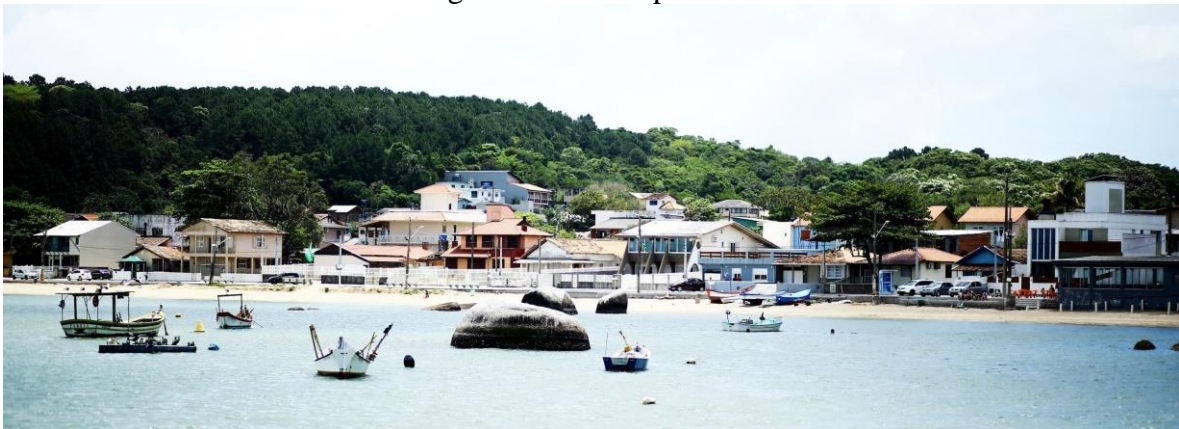
Figura 12 – Vista para a orla.
