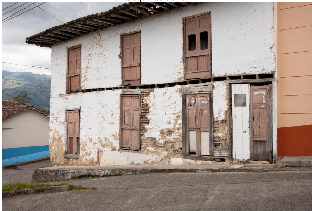
Figura 3 - PCCC- Salamina, Caldas. Bien de Interés Cultural Nacional - BICN- Bahareque de tierra.
