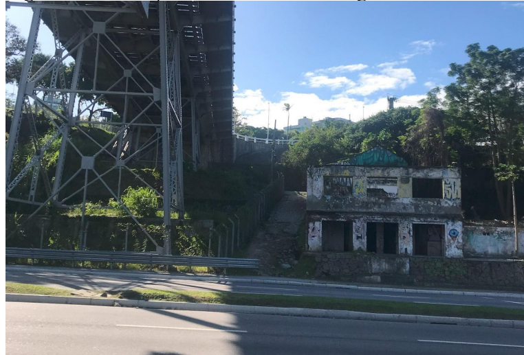
Figura 3 – Edificação remanescente do antigo Estaleiro Arataca.
