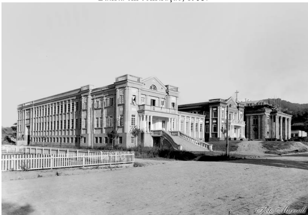
Figura 4 – Simão Gramlich (projeto arquitetônico), Gino de Lotto (execução). Colégio Dom Bosco (1941-1951). Rio do Sul. À direita, Catedral São João Batista em construção, 1953.
