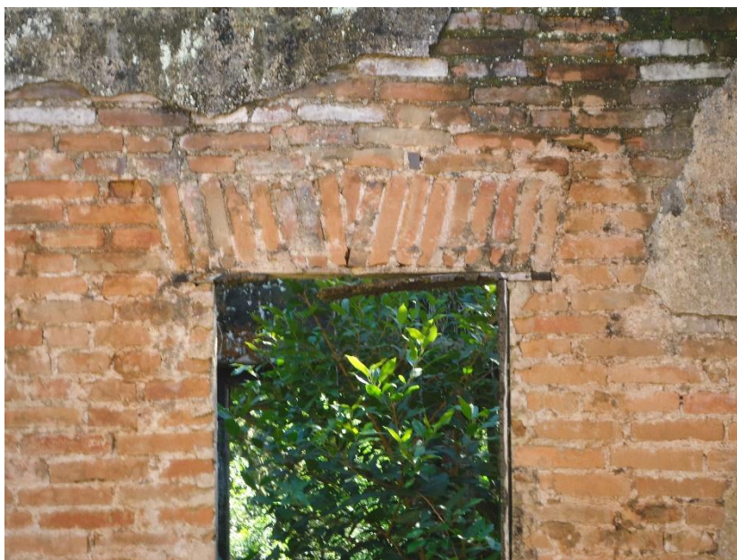
Figura 5: Parede de Tijolo Maciço.
