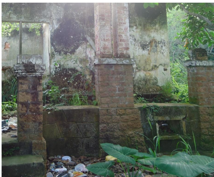
Figura 6: Detalhe da falsa cantaria.
