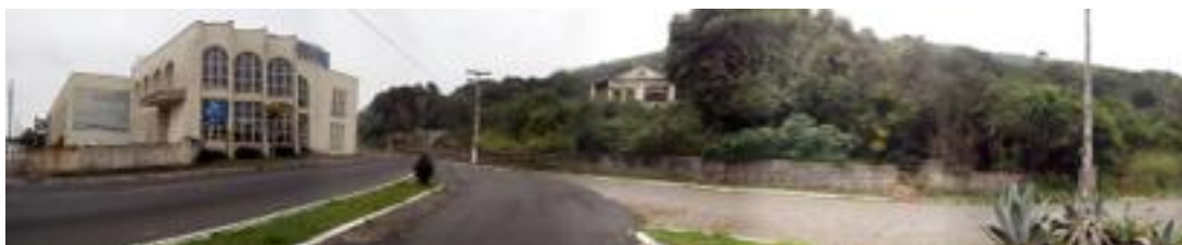
Figura 3: Panorâmica da Ruína Mussi.
