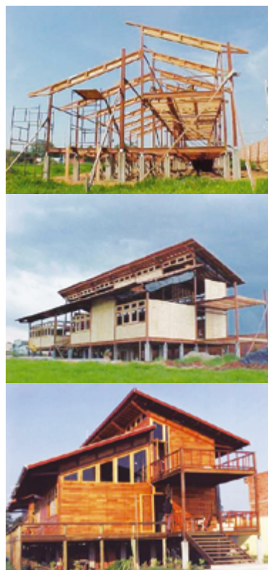
Figura 1: IMAFLORA I - Montagem da estrutura, vedação e acabamento
