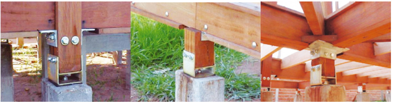
Figura 3: IMAFLORA I – Interfaces pilar-fundação e pilar-viga composta
