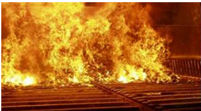
Figura 27: Queimadura dos resíduos na grelha inclinada móvel.
