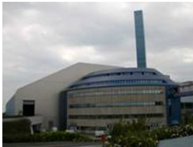
Figura 23: Vista externa do termoutilizador.
