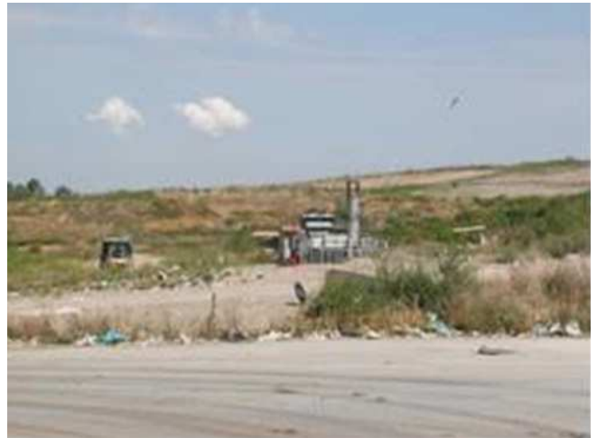
Figura 13: Produção de biogás, que gera a eletricidade necessária para o funcionamento do complexo, e pequeno adicional para o uso pela população.
