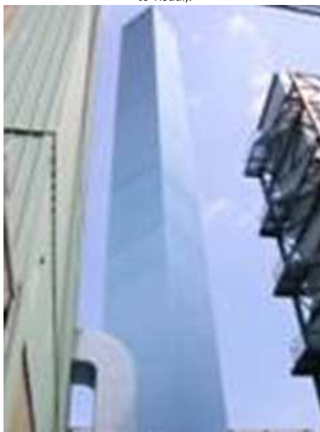
Figura 24: Chaminé contra o céu no período da manhã; vista de alguns ângulos, é quase invisível (baixo impacto visual).
