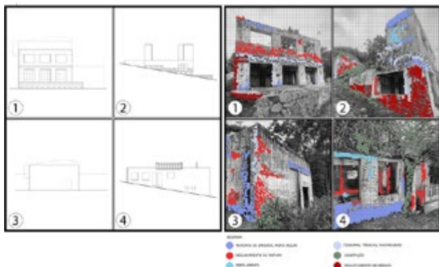
Figura 05: Cartograma de las Patologías Constructivas de las Ruinas del Astillero Arataca
