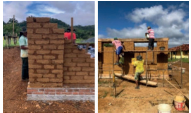
Figura 02: Escola do Assentamento João Amazonas. Fonte: acervo pessoal dos autores (2023).
