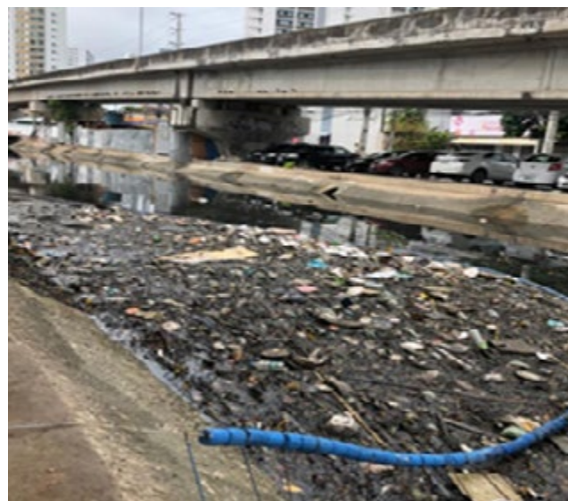
Figura 06 - Material espreado na parede do canal, para ser removido no Canal do Setúbal.
