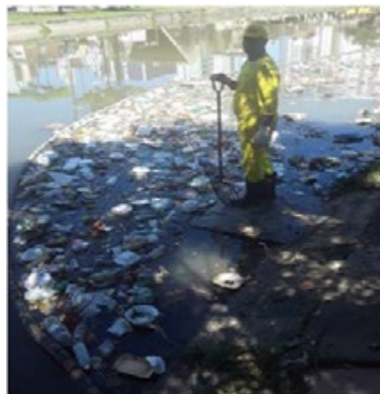
Figura 10 - Plataforma de acesso, criada para auxiliar o processo de limpeza das ecobarreiras.
