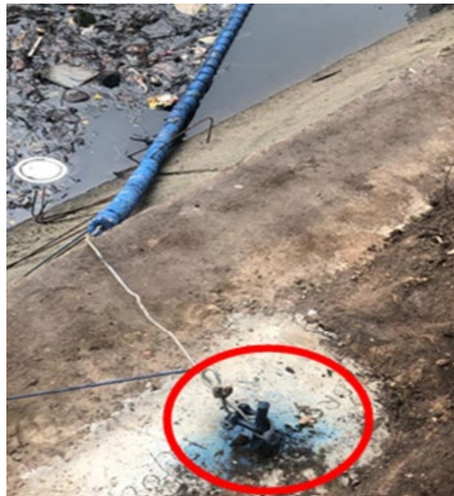
Figura 05 - Detalhe do ponto de fixação das Ecobarreiras.
