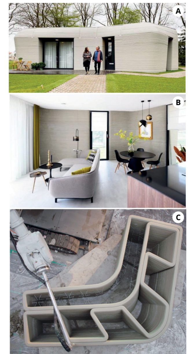
Figura 9: Vista exterior (a) e interior (b) da casa e (c) parte da parede. Fonte: 3D PRINTED HOUSE (2023).
