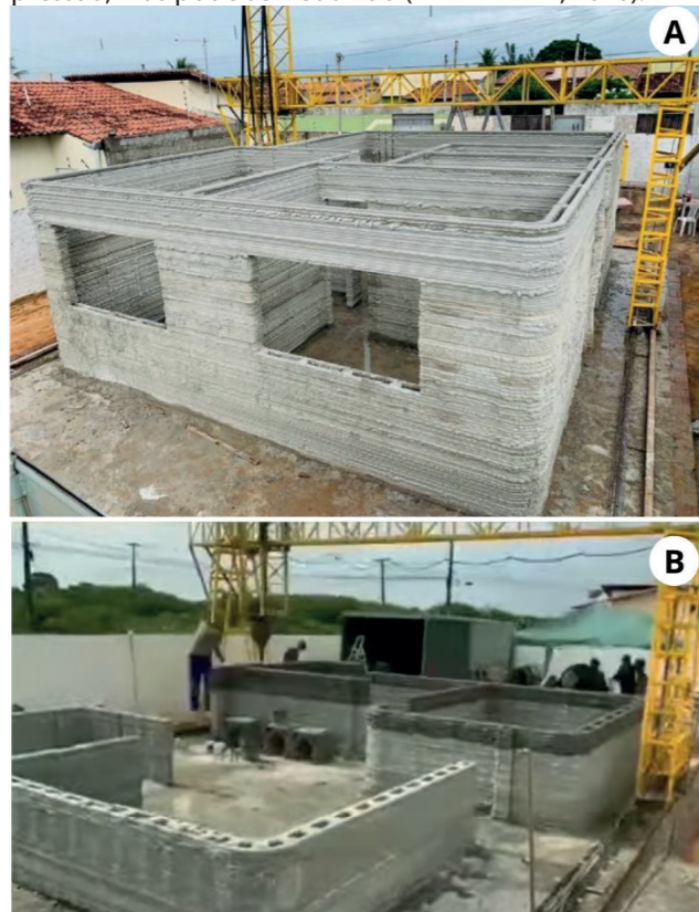
Figura 10: Vista do processo de impressão das paredes da casa (a) e (b). Fonte: MARTINELLI (2020).
