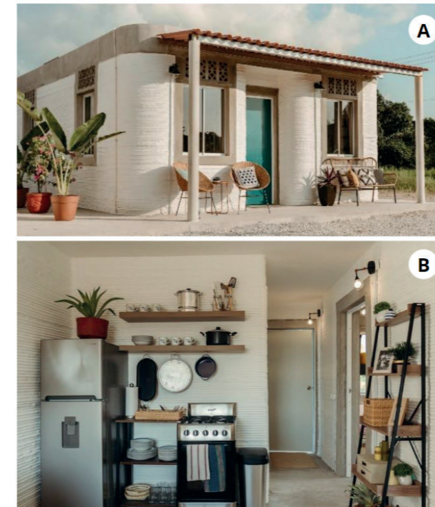
Figura 4: Vista externa (a) e interna (b) da casa. Fonte: ICON (2023).
