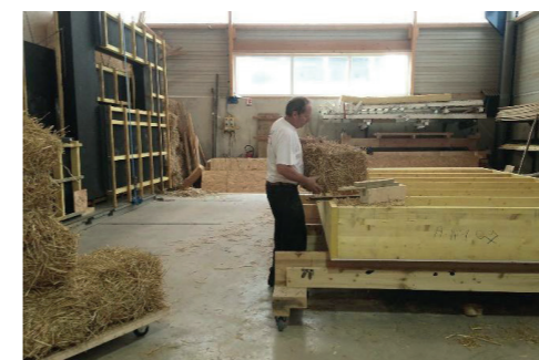
Figura 16: Processo de pré-fabricação dos painéis. Fonte: NZI Architectes.
