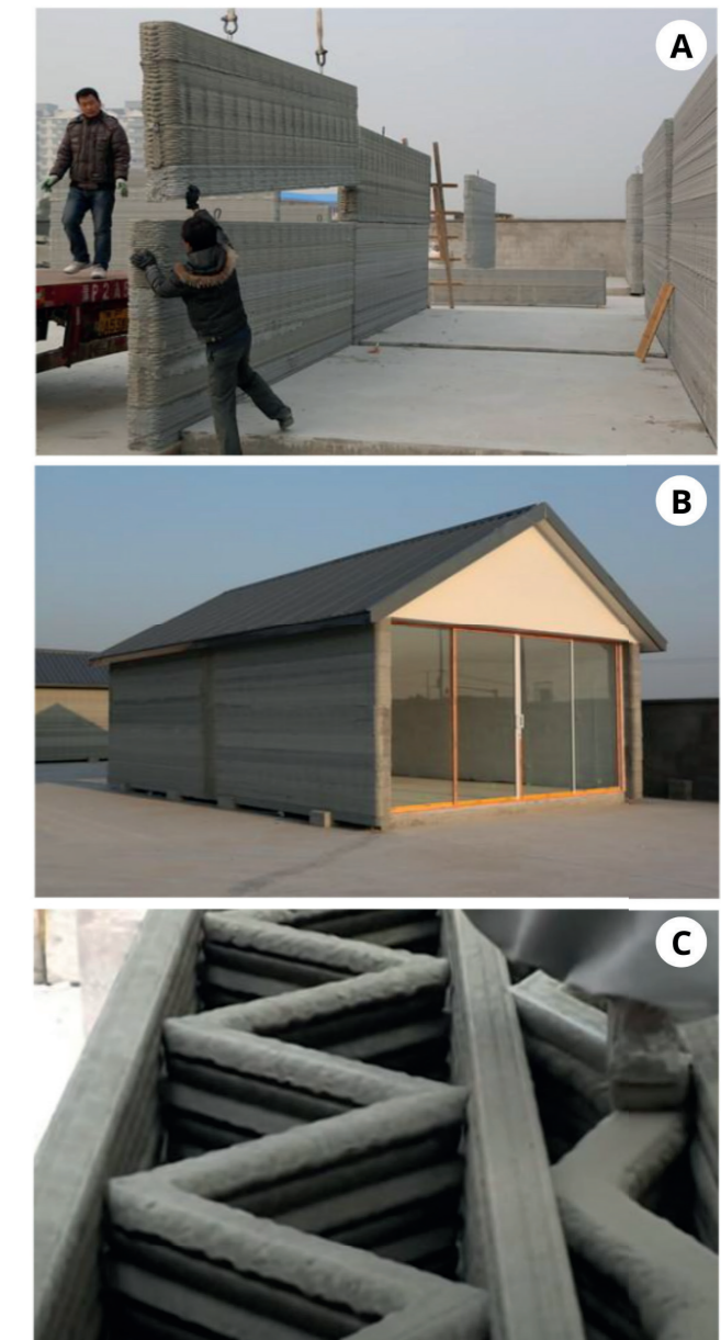
Figura 1: (a) Montagem de parede, (b) casa finalizada e (c) estrutura do elemento pré-fabricado. Fonte: Walker (2014).
