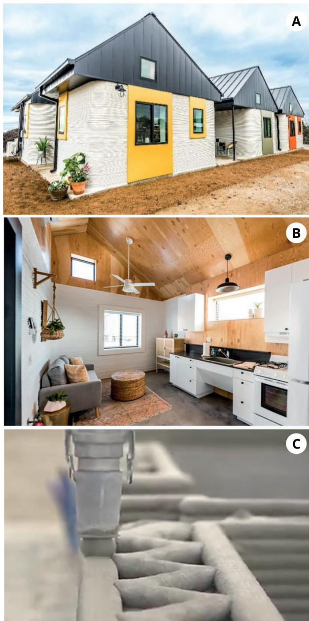
Figura 5: Vista externa (a) e interna (b) de uma das casas e impressão da parede (c). Fonte: ICON (2023).
