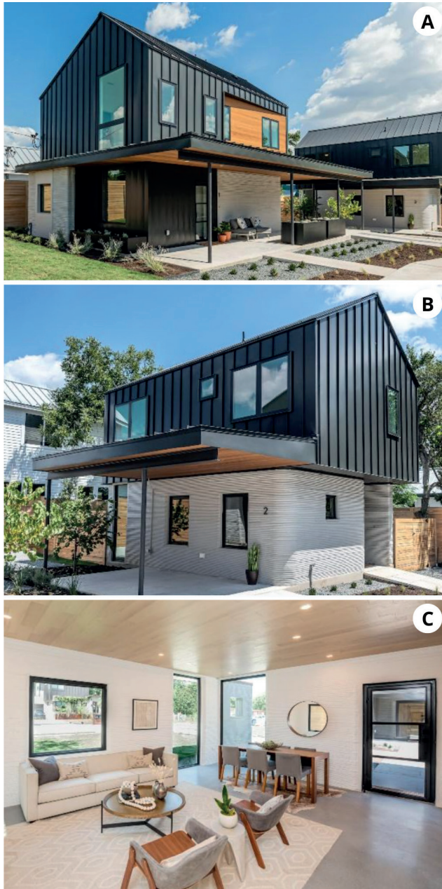
Figura 6: Vista externa (a) e (b) e interna (c) das casas. Fonte: ICON (2023).
