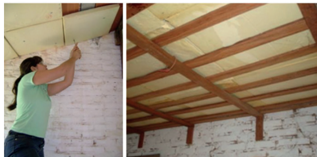
Figura 5: a) Colocação das placas de PU; b) Placas de PU aplicadas no forro. Fonte: CARDOSO, 2010.
