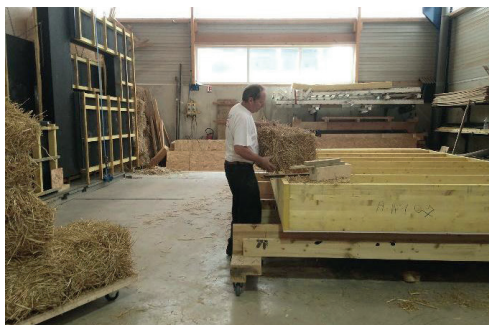
Figura 16: Processo de pré-fabricação dos painéis.
