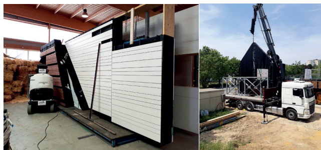
Figura 17: Processo de finalização e transporte dos painéis.
