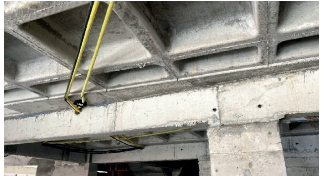
Figura 06: Passagens pré-definidas durante a etapa de concretagem utilizando caixas de resíduos de madeira. Fonte: Autores.
