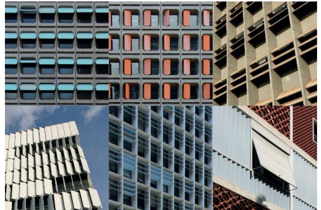
Figura 1: Levantamento fotográfico: diferentes tipos de brises. Fonte: Desenvolvido pelos autores (2023).
