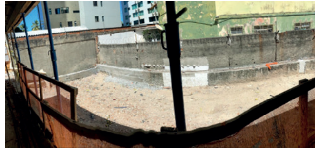
Figura 05: Reaterro utilizando resíduos de solos, concreto e areias. Fonte: Autores.
