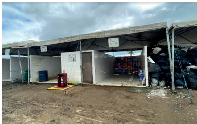
Figura 08: Baixas fixas para resíduos de madeiras, químicos, plástico, papelão e resíduos contaminados.
