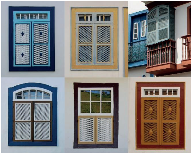
Figura 3: Levantamento fotográfico: treliçados de madeira protegendo janelas da radiação solar excessiva.
