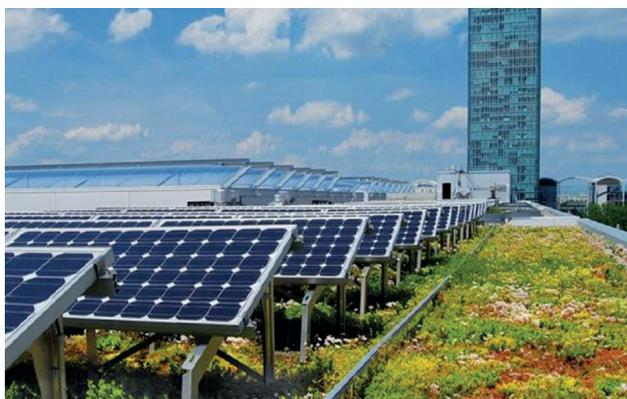
**Figura 9:** Exemplo de uma cobertura verde fotovoltaica.
