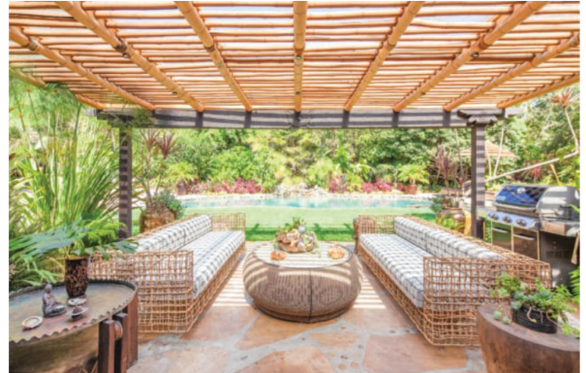
Figura 02 – Pergolado construído com bambu Fonte: DoceObra, 2021.
