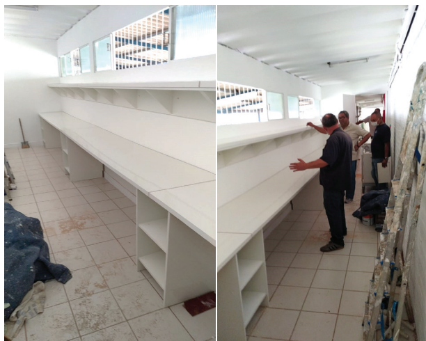
Figura 8 (a) e (b) - Instalação do laboratório do novo Fab.i HU. Fonte: Autores.
