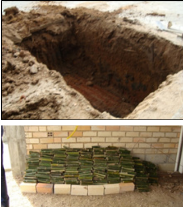
Figura 2 - (a) Vala escavada para o início da execução (b) Pequenos pedaços de bambu para a execução do tratamento. Fonte: Autores (2016).
