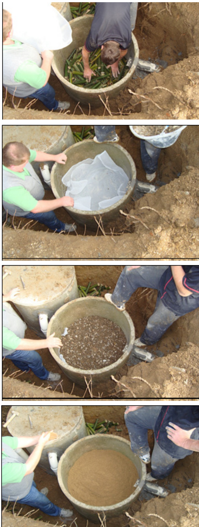
Figura 5 - (a) Filtro de bambu no último tubo; (b) Tela para separação da areia e bambu; (c) Colocação da brita número 2; (d) Colocação da camada de areia fina. Fonte: Autores (2016).
