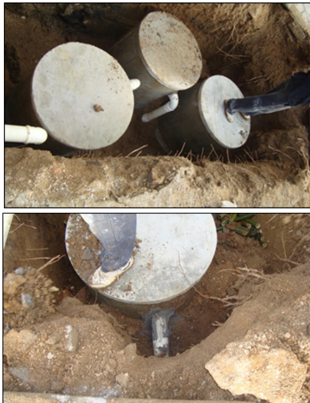
Figura 6 – (a) Execução concluída; (b) Ligação do tratamento até a drenagem da rua. Fonte: Autores (2016).
