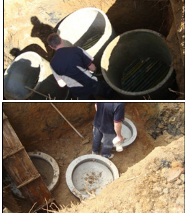
Figura 3 - a) Fundos sendo colocado na vala. b) Tampas de bambu para o início da filtragem. Fonte: Autores (2016).
