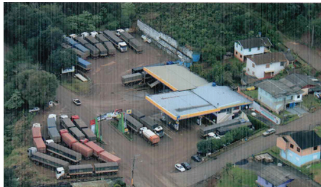
Figura 1 - Imagem aérea da cobertura do posto de combustível.
