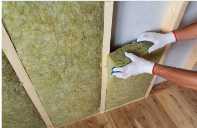
Figura 01 – Instalação de painel de lã de vidro Fonte: GESSO SUL, 2020
