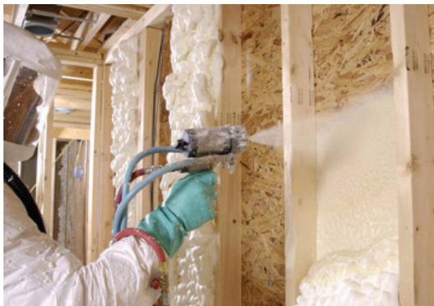
Figura 02 – Aplicação de espuma de poliuretano como isolante entre duas paredes Fonte: INTONACO, 2020
