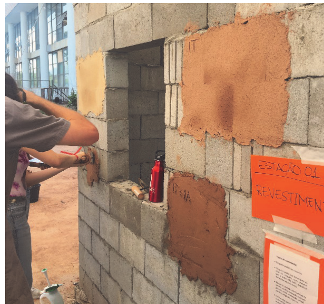
Figura 01 - Aplicação de revestimento de terra sobre alvenaria de blocos de concreto durante o evento Terra Brasil 2018, Rio de Janeiro Fonte: Autores (2018).
