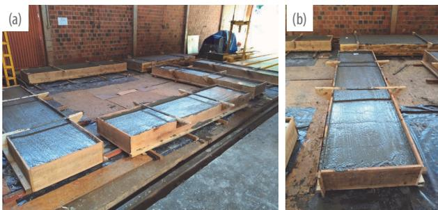
**Figura 06** - Lajes recém concretadas
