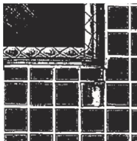
**Figura 14** – Imagem da manifestação patológica binarizada: presença de eflorescência na fachada Sul
