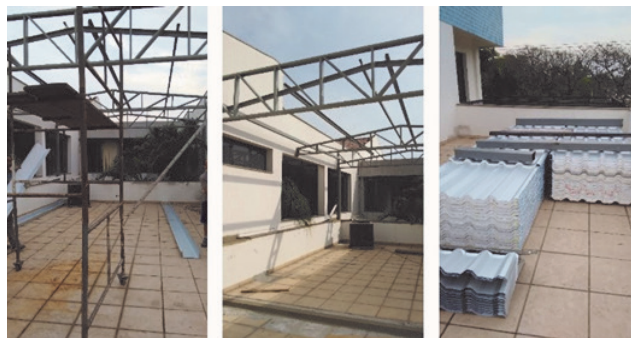
Figura 17 - Nova estrutura metálica do Departamento Financeiro Fonte: Os autores
