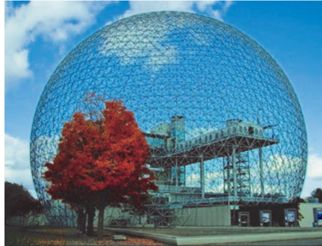
Figura 2 - Cúpula geodésica, biosfera de Montreal no Parque Jean - Drapeau. Fonte: Maia, R.
