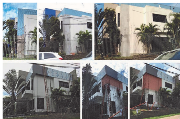
Figura 18 - Fachada durante a reforma Fonte: Os autores
