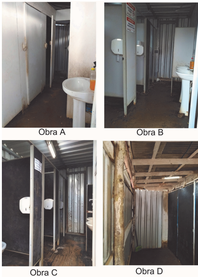
Figura 08 – Fotos da Instalação Sanitária das obras A, B, C e D. Fonte: Autores, 2019.
