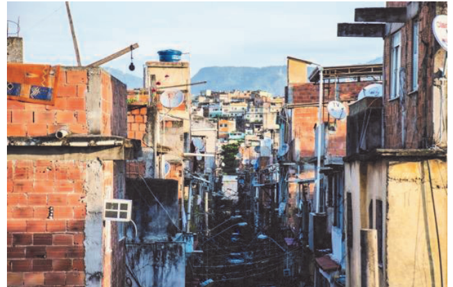
Figura 04 – Nova Holanda (1962) com vista para Morro do Timbau (1942). Foto: Douglas Lopes, 2017
