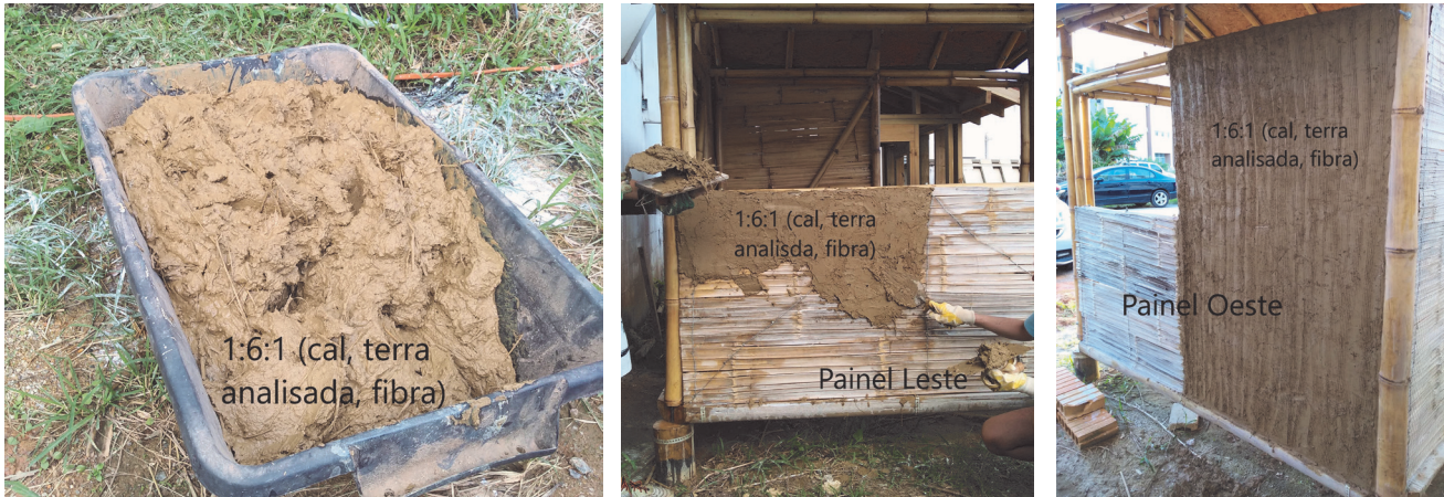
Figuras 08, 09 e 10 – Elaboração, aplicação e texturização do emboço a base de terra estabilizado com cal e fibra Fonte: Autores, 2019
