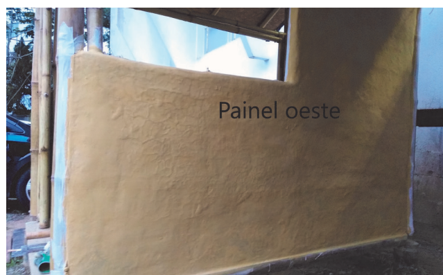
Figuras 19, 20 e 21 – Pigmento, caiação e coloração final do painel oeste Fonte: Autores, 2019
