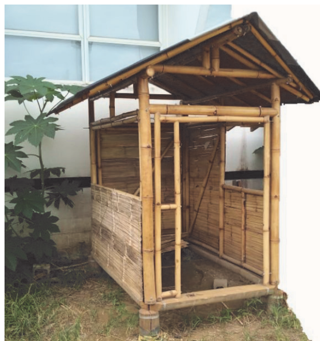
Figura 02 – Estrutura edificada em técnica mista por Vitor (2018) Fonte: Autores, 2019
