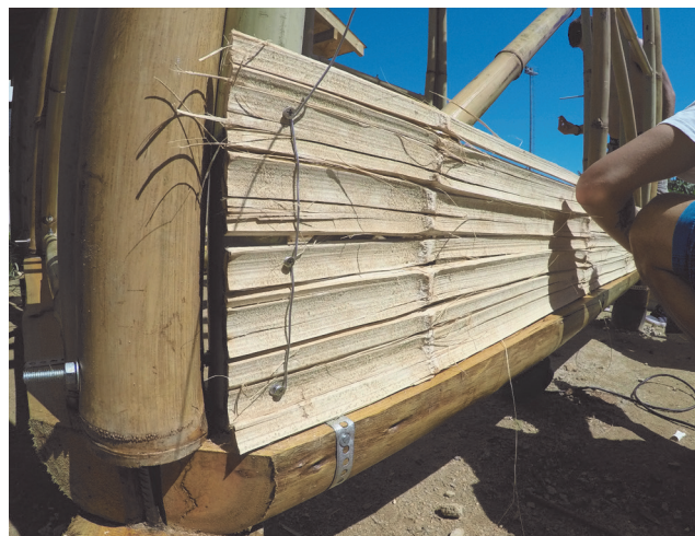
Figura 01 – Fixação das esteiras de bambu. Fonte: Vitor, 2018
