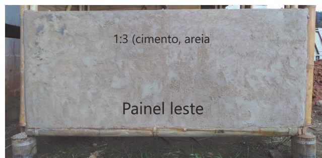
Figuras 17 e 18 – Aplicação do reboco a base de areia na integridade do painel leste do protótipo Fonte: Autores, 2019
