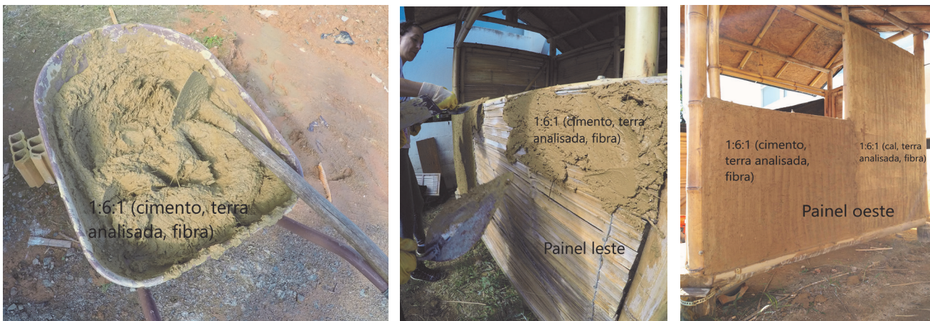
Figuras 11, 12 e 13 – Elaboração, aplicação e texturização do emboço a base de terra estabilizado com cimento e fibra Fonte: Autores, 2019
