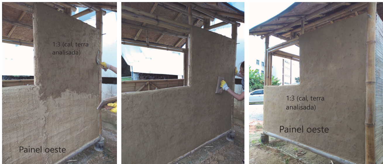
Figuras 14, 15 e 16 – Aplicação do reboco a base de terra na integridade do painel oeste do protótipo Fonte: Autores, 2019
