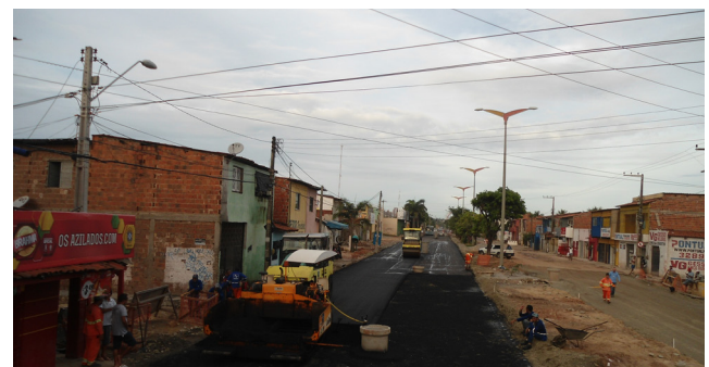
Figura 5 – Execução do revestimento asfáltico Fonte: Prefeitura de Fortaleza, 2014
