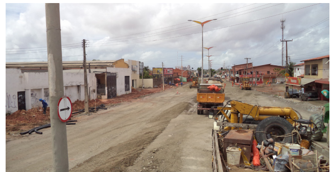
Figura 4 – Execução da base em BGS reciclado, na Av. Paulino Rocha, estaca 37. Fonte: Prefeitura de Fortaleza, 2014
