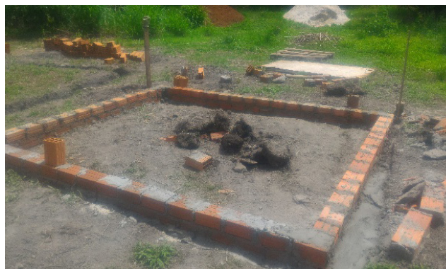
Figura 02 – Alicerce em tijolos cerâmicos furados
