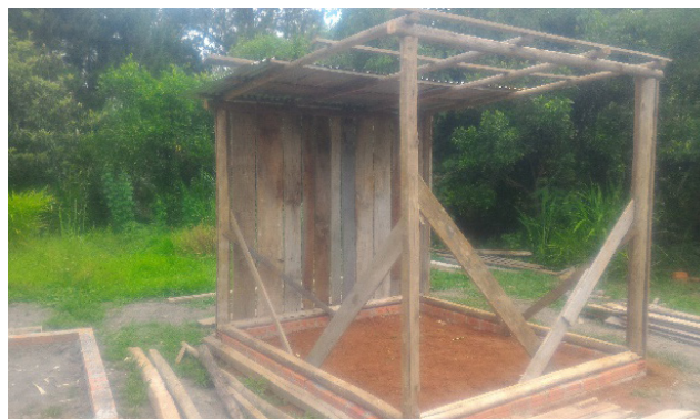
Figura 03 – Estrutura e revestimento de madeira usados
