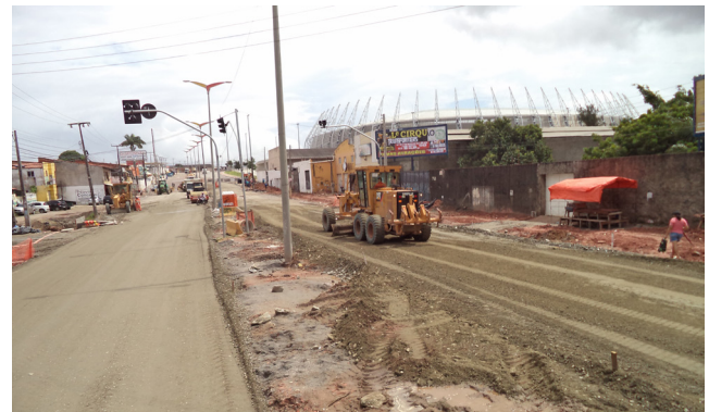
Figura 3 – Execução da base em BGS reciclado, na Av. Paulino Rocha, estaca 36+00m Fonte: Prefeitura de Fortaleza, 2014
