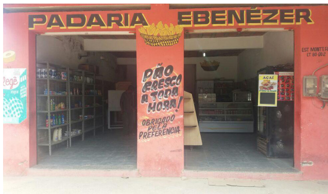
Figura 2 – Fachada do Empreendimento Estudado Fonte: Autores
