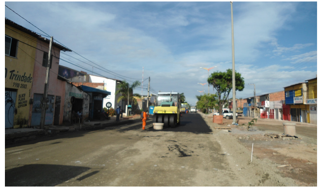
Figura 2 – Av. Paulino Rocha em sua execução Fonte: Prefeitura de Fortaleza, 2014
