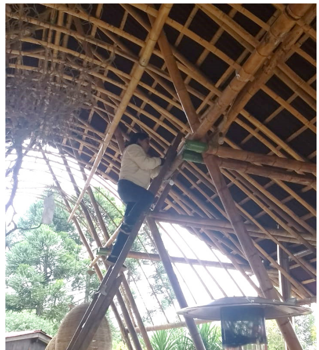
Figura 4 – Inspeção visual de estrutura de bambu Fonte: Autores.
