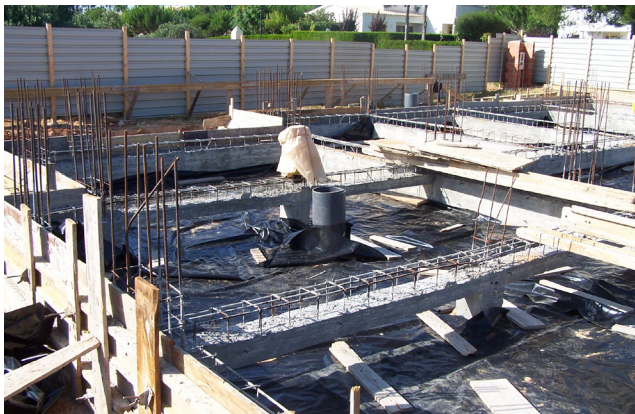
Figura 12 e 13 – Preparação e Isolamento do Pleno Fonte: AlmaVerde.
