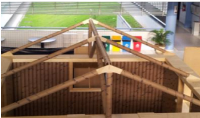
Figura 10 – Estrutura da cobertura com tubos de papel Fonte: Zaparoli (2013).
