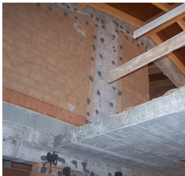
Figura 19 e 20 – Preparação do Reboco Fonte: AlmaVerde.
