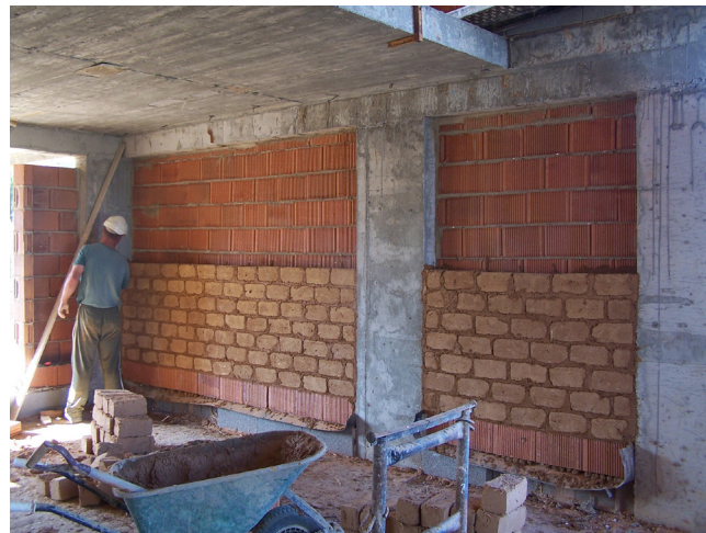
Figura 15 – Execução da Alvenaria Fonte: AlmaVerde.
