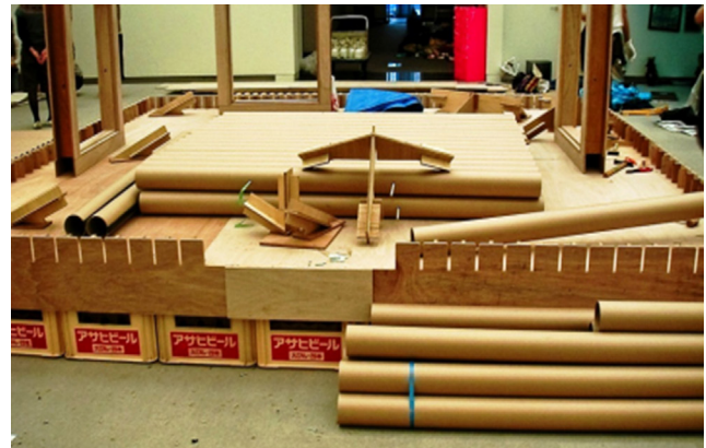
Figura 5 – Montagem da Paper Log House Fonte: Ferreira (2011).
