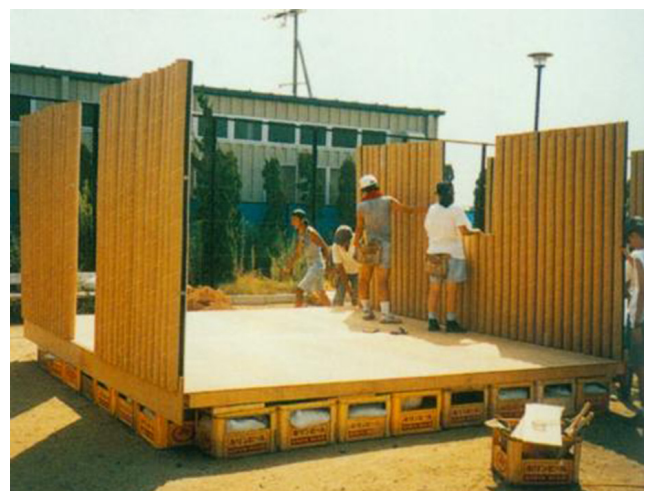
Figura 6 – Montagem da Paper Log House Fonte: Ferreira (2011).
