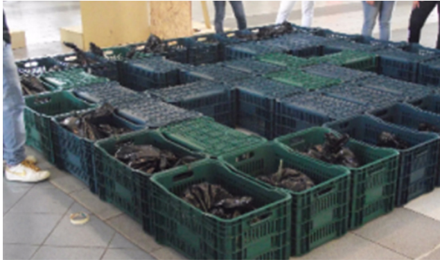
Figura 9 – Fundação feita de caixas de fruta com sacos de areia Fonte: Zaparoli (2013).
