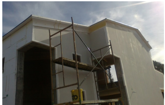
Figura 24 a 26 – Isolamento e Reboco Exterior Fonte: AlmaVerde.
