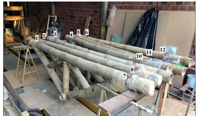
**Figura 15** – Concretagem dos apoios das tesouras
