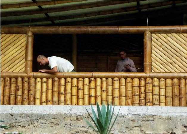
**Figura 4:** Trabalhadores montando uma parede de bambu, Paraty – RJ (2016).
