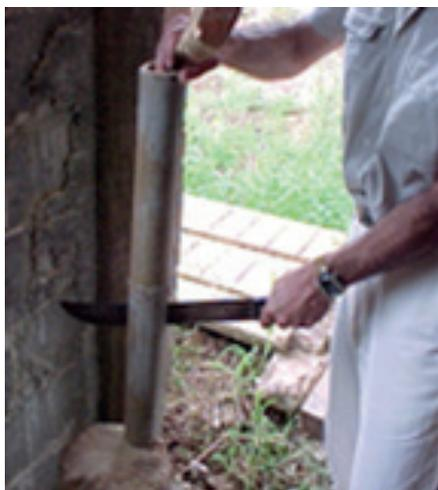
**Figura 7:** Corte de colmo de bambu ao meio com facão e macete.
