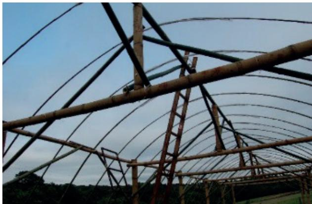
**Figura 1:** Estufa de *D. asper* e *P. aurea*, modelo CPRA, sendo construída no IAPAR-Pato Branco, (2016).
