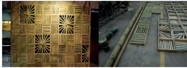
**Figura 10:** Painel com elementos modulares de bambu e madeira.
