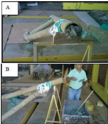
**Figura 6** – Inserção de concreto no apoio
