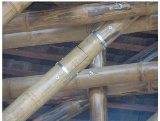
**Figura 9** – Abraçadeira metálica reforçando peça de bambu na chácara do sindicato dos professores (DF)
