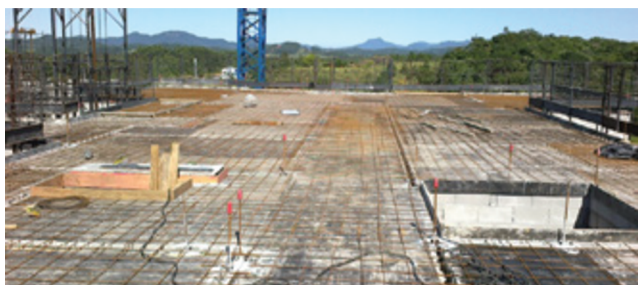
Figura 03: Formas para concretagem do in loco .
