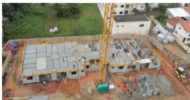
Figura 05: Montagem das lajes pré-fabricadas.
