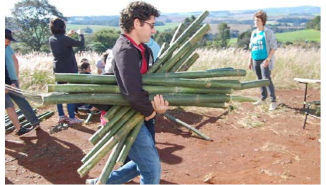
Figura 03: Segmentos de colmos de bambu tuldoises selecionados para serem usados na estrutura geodésica.
