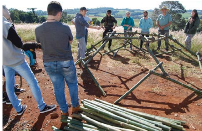
Figura 07: Segundo e terceiro nível da estrutura, construção de pentágonos e hexágonos regulares.
