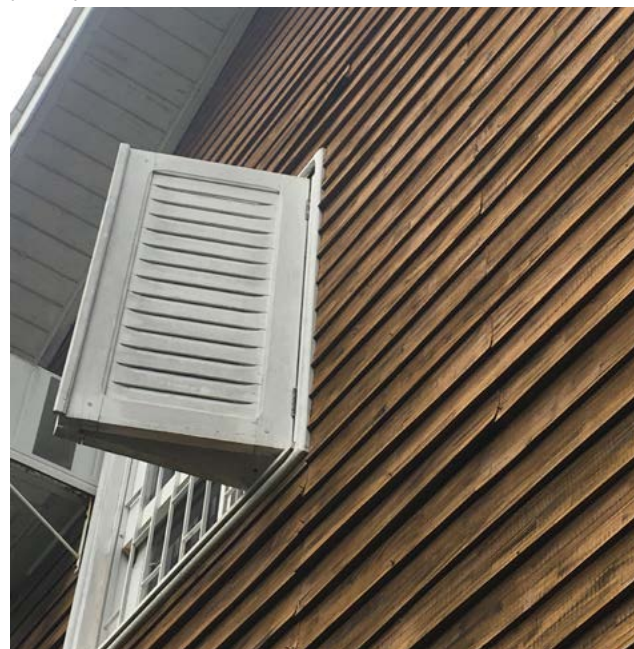
Figura 01: Deformação nas juntas e exposição do painel à umidade no protótipo Stella-UFSC.
