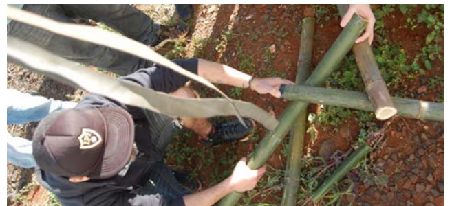
Figura 04: Disposição inicial do elemento triangular básico e amarração do triângulo com tiras de borracha.
