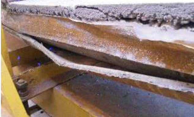
Figura 15 – Deslocamento da aba do bambu externo.
