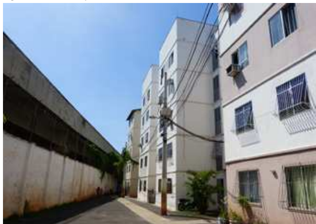
Figura 04: Viaduto junto ao muro do Bairro Carioca
