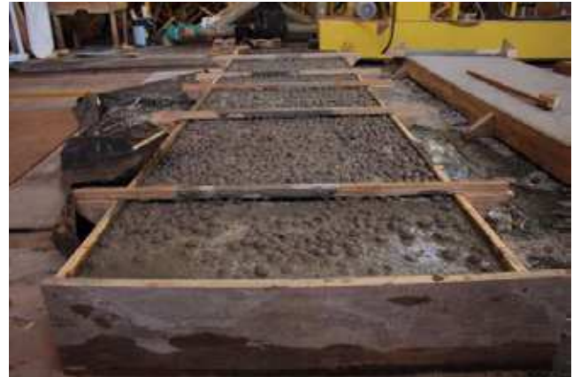
Figura 10 – Laje após regularização da capa.
