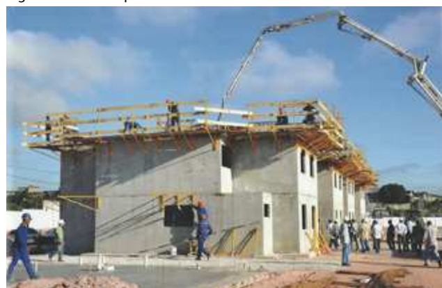
Figura 05: Paredes pré-moldadas em concreto
