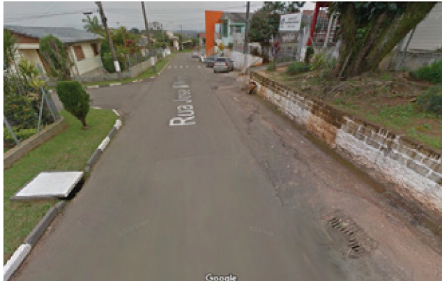
Figura 1 - Rua do recorte da Grande Santa Luzia, com a falta de padrão ou ausência de passeio público.
