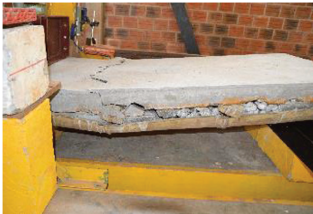
Figura 18 – Ruptura da capa de concreto.
