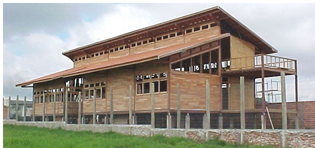
Figura 2 - Construção da estrutura em bambu para a Sede do Viverde Horto de Aimorés Bauru – SP
