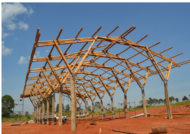
Figura 2 - Construção da estrutura em bambu para a Sede do Viverde Horto de Aimorés Bauru – SP
