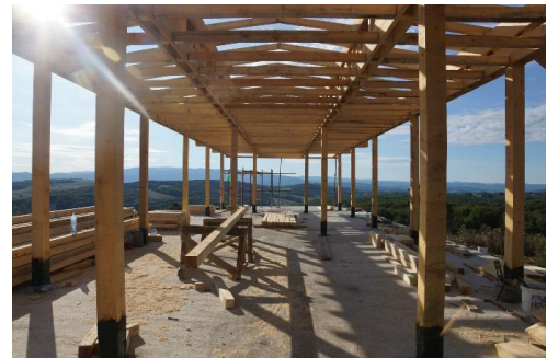
Figura 12: Processo de construção. Fonte: ArchDaily.
