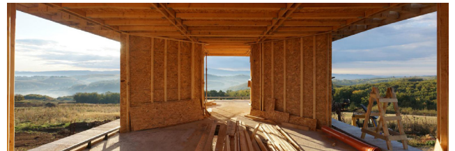
Figura 13: Processo de construção. Fonte: ArchDaily.
