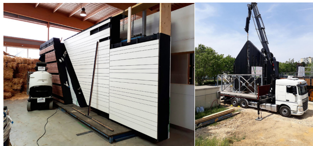
Figura 17: Processo de finalização e transporte dos painéis. Fonte: NZI Architectes.
