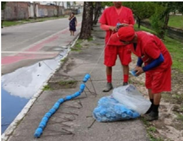
**Figura 04** -Montagem da Ecobarreira.
