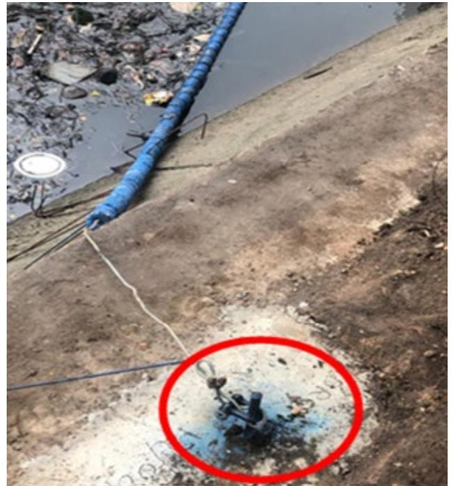
**Figura 05** - Detalhe do ponto de fixação das Ecobarreiras.
