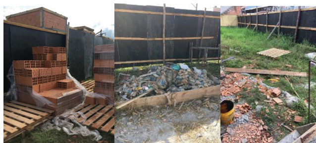
Figura 06 – Armazenamento/organização dos blocos cerâmicos e resíduos do canteiro de obras Fonte: as autoras (2018)
