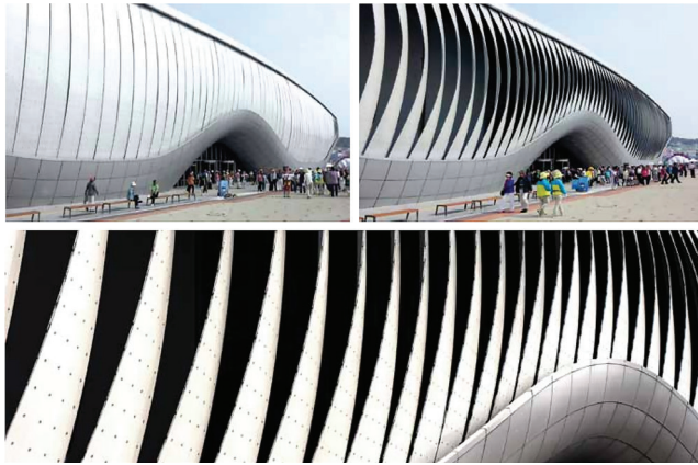
Figura 02 - A fachada do Thematic Pavilion, em Yeosu, na Coreia do Sul, utilizou estruturas Flectofin em sua fachada
