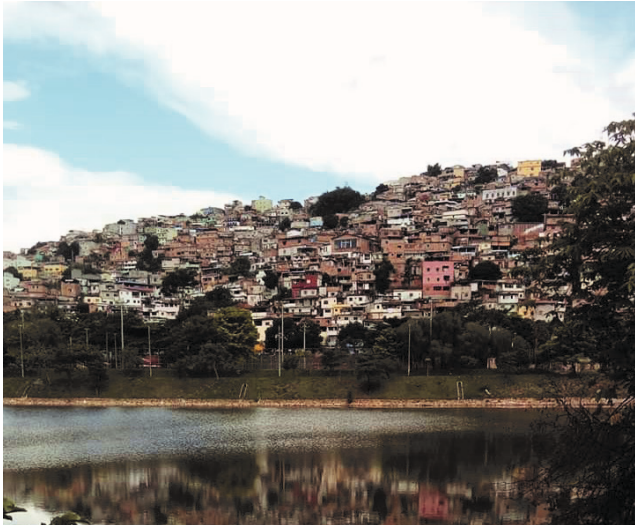
Figura 01 – Barragem Santa Lúcia, ao fundo o Morro do Papagaio – Belo Horizonte. Foto: Maikon Sipriano, 2019 Fonte: Maikon Sipriano, 2019.
