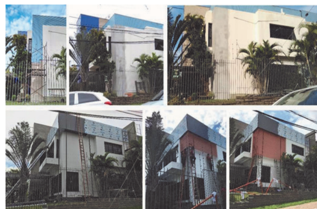
Figura 18 - Fachada durante a reforma Fonte: Os autores
