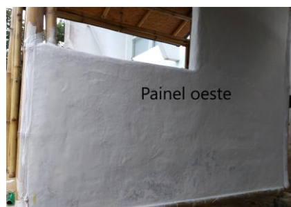
Figuras 19, 20, 21 – Pigmento, caiação e coloração final do painel oeste
