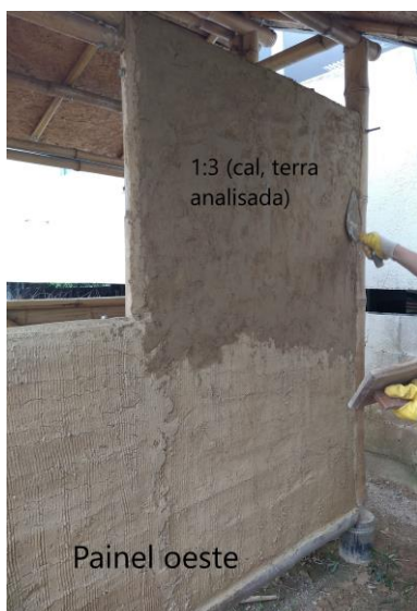
Figuras 14, 15 e 16 – Aplicação do reboco a base de terra na integridade do painel oeste do protótipo
