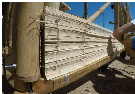
Figura 01 – Fixação das esteiras de bambu.
