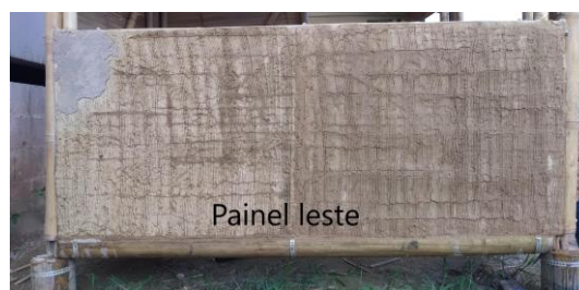
Figuras 17 e 18 – Aplicação do reboco a base de areia na integridade do painel leste do protótipo
