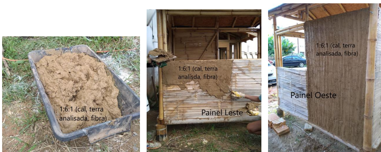
Figuras 08, 09 e 10 – Elaboração, aplicação e texturização do emboço a base de terra estabilizado com cimento e fibra
