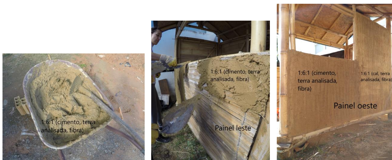
Figuras 11, 12 e 13 – Elaboração, aplicação e texturização do emboço a base de terra estabilizado com cal e fibra
