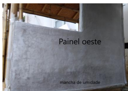
Figuras 19, 20, 21 – Pigmento, caiação e coloração final do painel oeste
