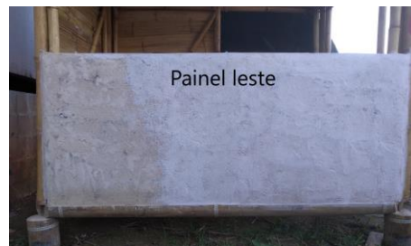
Figuras 22, 23 e 24 – Pigmento, caiação e coloração final do painel leste
