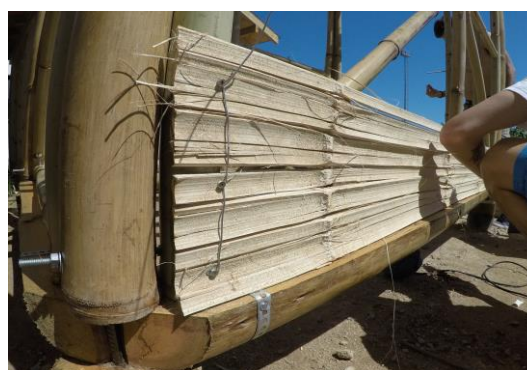
Figura 01 – Fixação das esteiras de bambu.
