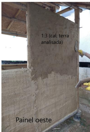
Figuras 14 e 15 – Aplicação do reboco a base de terra na integridade do painel oeste do protótipo
