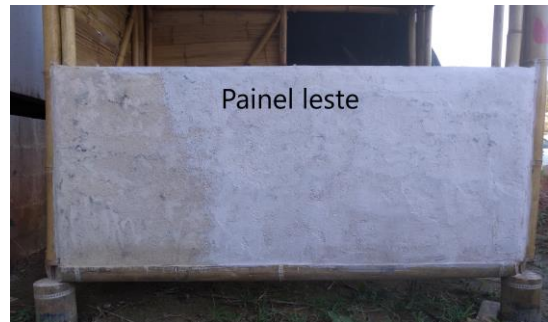
Figuras 22, 23 e 24 – Pigmento, caiação e coloração final do painel leste
