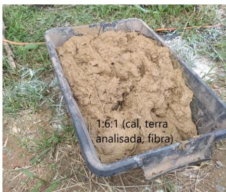
Figuras 11, 12 e 13 – Elaboração, aplicação e texturização do emboço a base de terra estabilizado com cal e fibra
