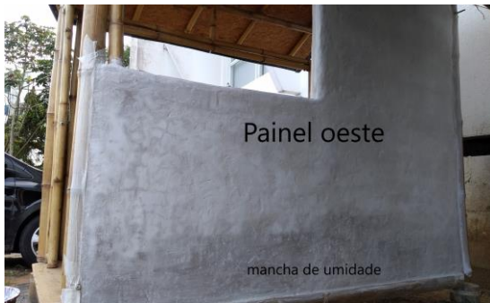
Figuras 19, 20, 21 – Pigmento, caiação e coloração final do painel oeste
