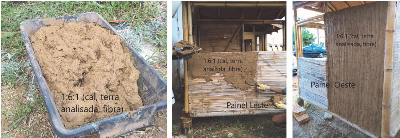
**Figuras 08, 09 e 10** – Elaboração, aplicação e texturização do emboço a base de terra estabilizado com cal e fibra
