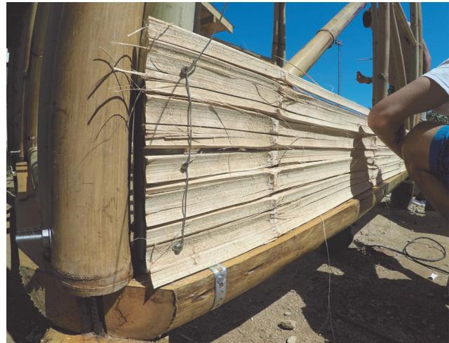
**Figura 01** – Fixação das esteiras de bambu.
