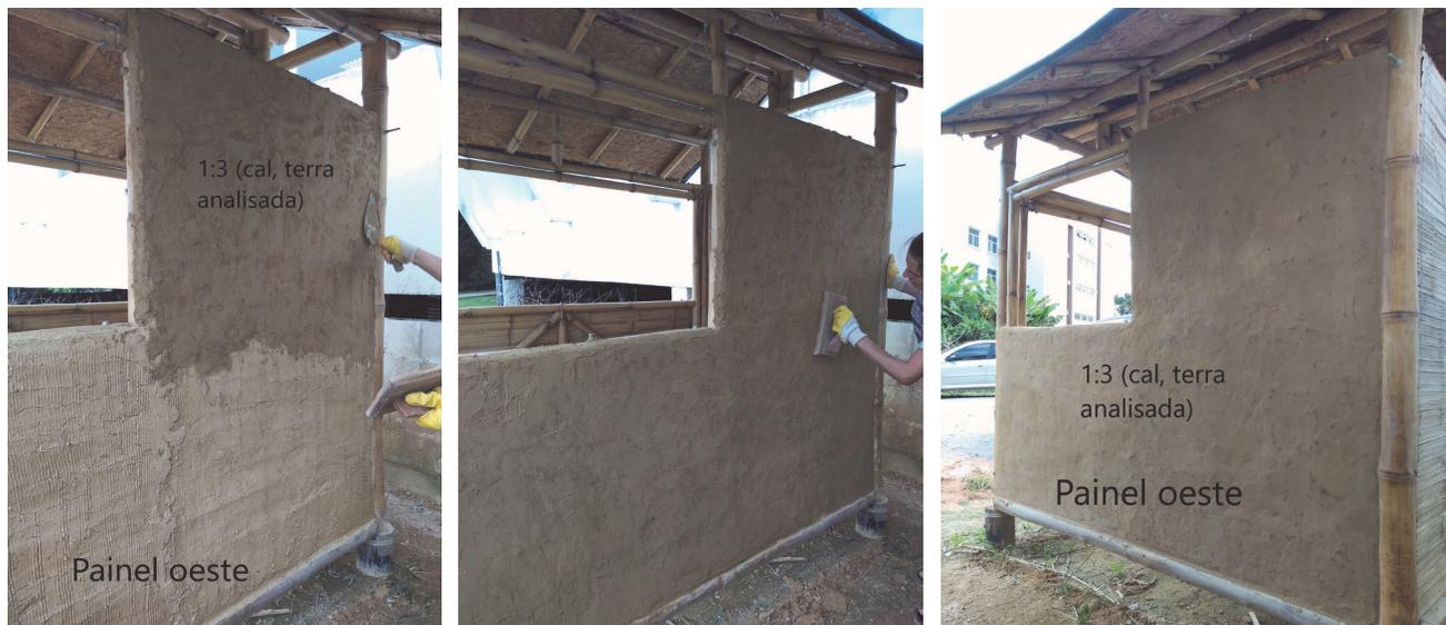
**Figuras 14, 15 e 16** – Aplicação do reboco a base de terra na integridade do painel oeste do protótipo
