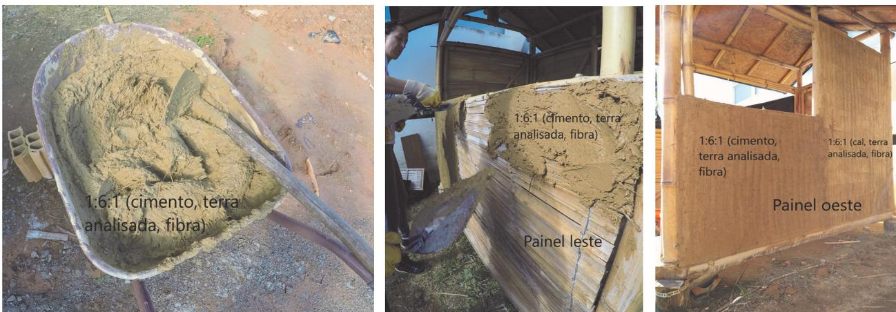
**Figuras 11, 12 e 13** – Elaboração, aplicação e texturização do emboço a base de terra estabilizado com cimento e fibra
