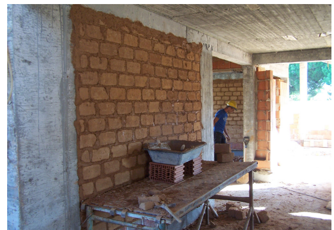
Figura 10 e 11 – Colocação de Adobe Fonte: AlmaVerde.
