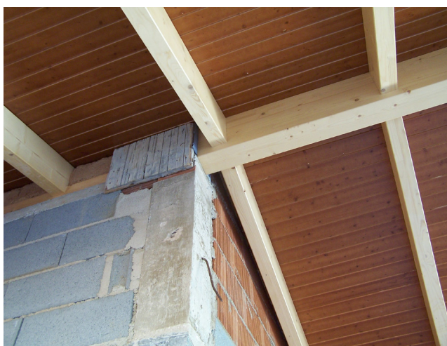
Figura 16 a 18 – Vigas e Painéis da Cobertura Fonte: AlmaVerde.
