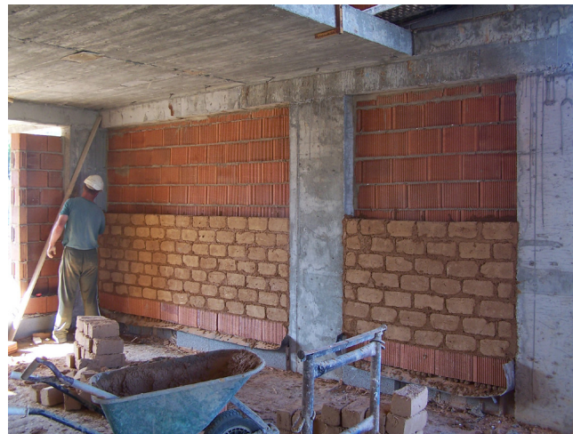
Figura 15 – Execução da Alvenaria Fonte: AlmaVerde.
