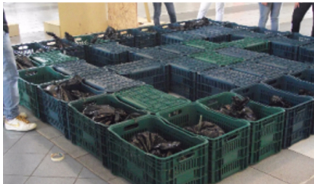
Figura 9 – Fundação feita de caixas de fruta com sacos de areia Fonte: Zaparoli (2013).
