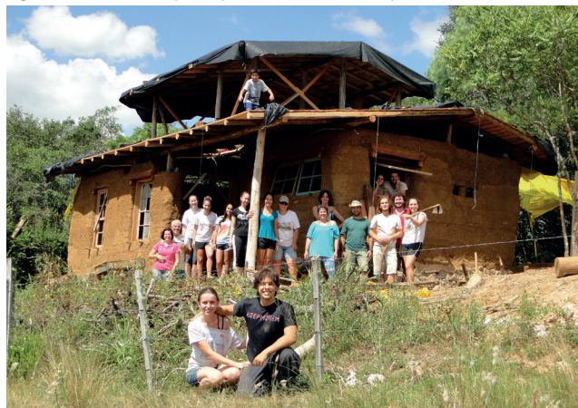
Figura 04 – Paredes quase prontas, no décimo quarto mutirão.
