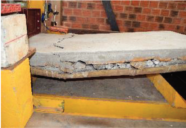
Figura 18 – Ruptura da capa de concreto.
