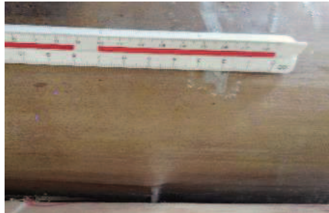
Figura 16 – Deslocamento local do bambu no centro da laje.
