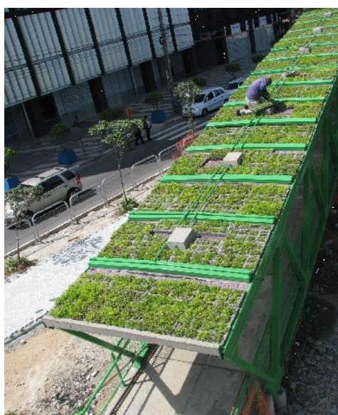
Figura 06 – Passarela ecológica – São Paulo.
