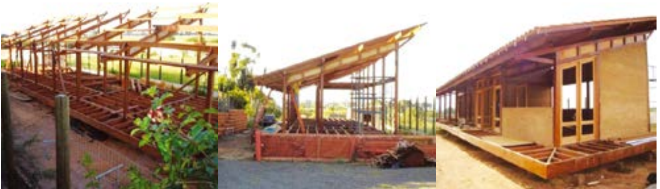
Figura 4: IMAFLORA II - Montagem da estrutura, vedação e acabamento
