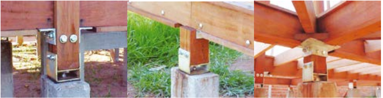
Figura 3: IMAFLORA I – Interfaces pilar-fundação e pilar-viga composta
