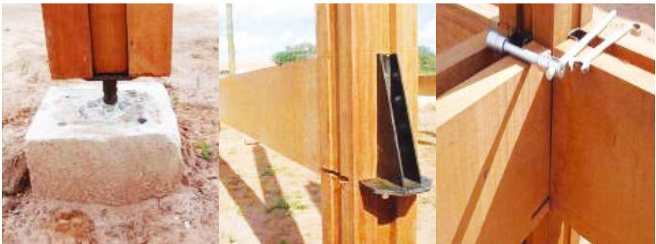
Figura 9: IMAFLORA II – Interfaces pilar-fundação e pilar-viga executadas em obra
