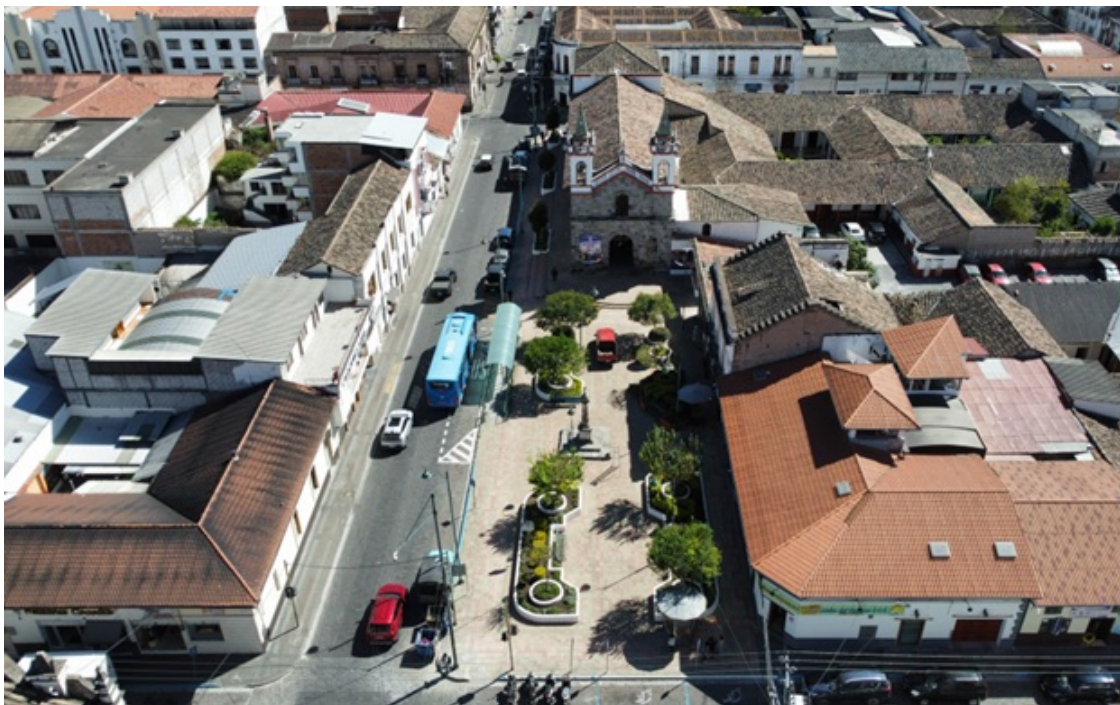
Figura 16 – Vista de la plazoleta y actual iglesia de San Agustín.
