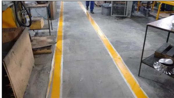
Figura 3 - Pintura de faixas no piso da fábrica
