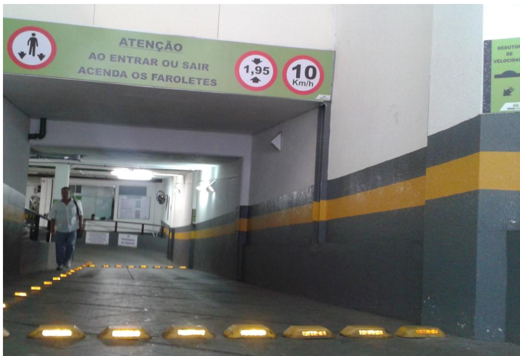
Figura 7 - Redutores de velocidade no estacionamento
