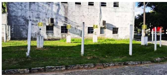
Figura 3. Receptores GNSS instaladas nos pilares
