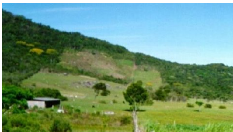
Fig. 08: Fotografia terrestre do local da área selecionada para aterro sanitário no Norte da Ilha de Santa Catarina
