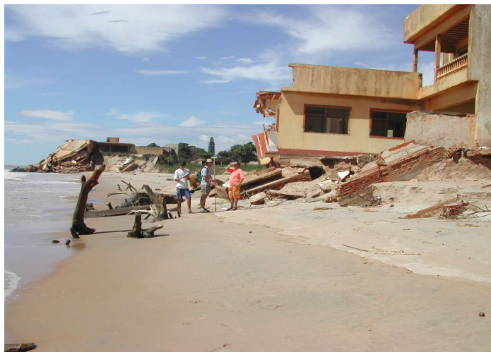
Figura 5: Fotografia indicativa de outras duas construções seriamente danificadas pela erosão próximas do pontal de Atafona.
