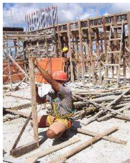
Figura 1 : Uso de equipamentos rudimentares em obra
