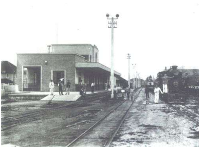
figura 10: Estação Ferroviária – plataforma de embarque
